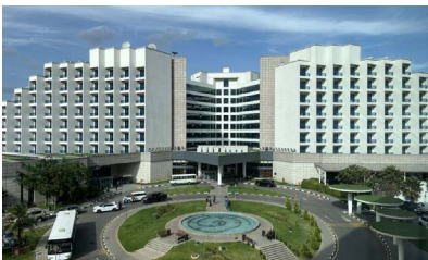
ADÍS ABEBA: SKYLIGHT HOTEL
